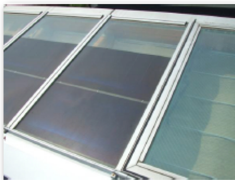
積水ハウス SDH 実験棟 トップガラス ガラス： 目的／防汚・環境浄 癒し・温度上昇抑制
