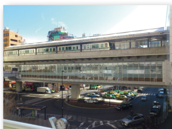
JR 日暮里駅、 舎人ライナー通路 外壁ガラス ガラス：目的／防汚
